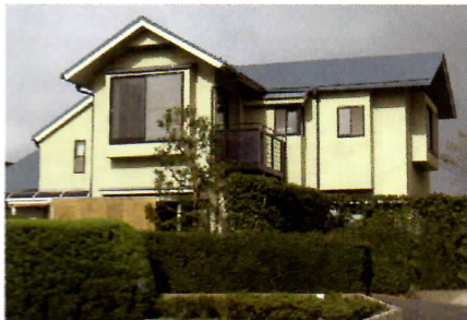
▲住環境の改善を図るため、築15年の戸建て住宅の屋根、外壁にガイナを塗布。
